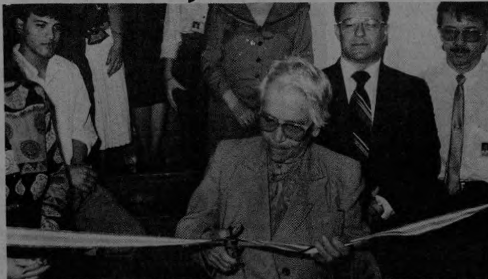
Doña Olivia Flores fue la encargada de inaugurar las obras de reconstrucción del edificio de la Junta de Pensiones del Magisterio. (A. Fonseca)
